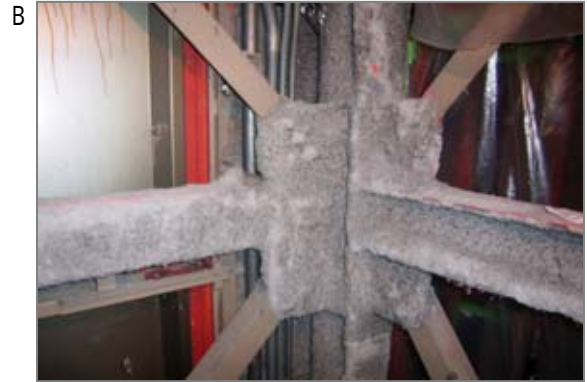
B エレベーターシャフト内(竖穴区画の吹きつけ石綿)。この閉ざされた空間をエレベーターは高速で何回も上下しているため粉じんが舞っているものと推測出来ます。修理、点検時に作業員が区画内に立ち入り、堆積した石綿粉じんが再飛散してばく露する可能性があります。
