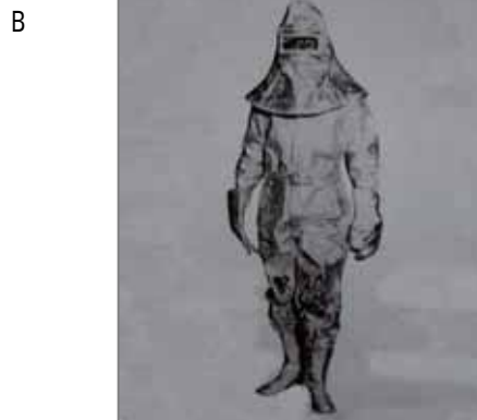
石綿布で出来た耐熱服。表面にアルミ箔などで覆い輻射熱も防ぎます。これらは製鉄のみならず消防や各分野で使用されてきました。現在はノンアス製品となっています。
