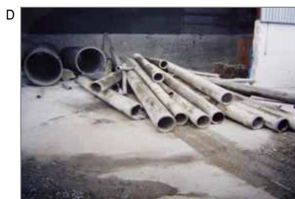
D 水道管の集積。尚、石綿セメント管という標記は上下水道用、石綿セメント円筒という標記は煙突など建築用に用います。
