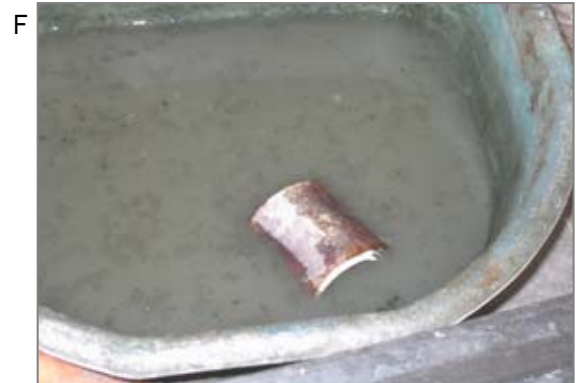
F 炉から取り出した筒と歯(リング)のつめものを外す水洗い場。筒(リング)とボロボロになった石綿リボンが残り、それを水洗します。水洗い場の周囲には粉じんが乾燥して白い粉としてこびりついています。
