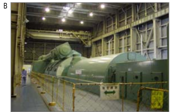
原子力・火力・地熱発電所の配管などに保温材として石綿含有保温材が取り付けられている場合があります。点検・工事時に保温材を取り外すと、石綿が飛散することがあります。
