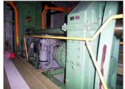
立体駐車場最上部ブレーキパッド(モーター内) (モーター内のためこの写真には写っていません)
