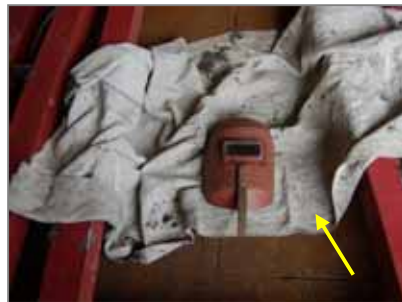
溶接火粉防止用石綿布(防護面体の下)
