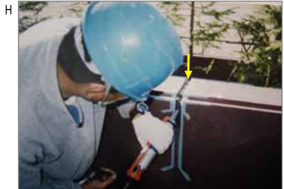
H シーリング(コーキング)作業。継ぎ目や隙間、クラック部などに充填します。以前のコーキング材にはかなりの含有率で石綿が入っていました。劣化するとボロボロになるものもあります。
