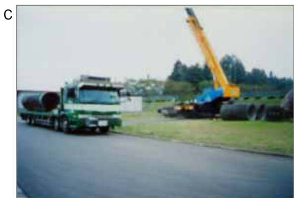
C この水道管の現在の撤去風景。振動により破損し、粉じんが飛散することがないよう、丁寧に運搬する必要があります。
