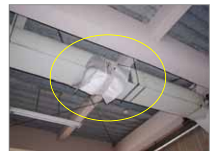
石綿保温材(石綿ふとん)
