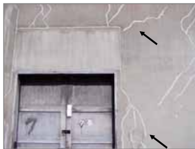
建物内外の漏水シール材として (壁のヒビを埋めているもの)
