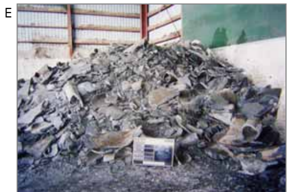
E この後に産業廃棄物として、粉碎して処分場に埋め立てられます。粉碎、埋め立て時に粉じんがかなり発生します。
