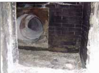
焼却炉などの内部・外部充填、塗込み
