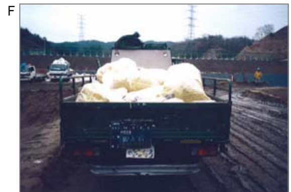
石綿(特別管理産業廃棄物)の収集・運搬・最終処分風景。石綿の入った袋が破れないように慎重に積み込み、運びます。
