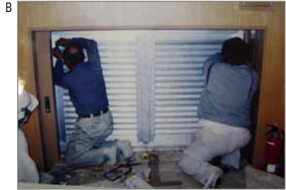
B サッシ工事(金属建具工事)。写真では判りづらいのですが内壁などに吹つけられている石綿を少し掻きとって鉄骨面から補強のリブ(力骨)などを入れる箇所があります。
