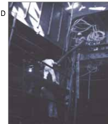
D 機関室内のボイラー作業。ボイラー炉内や外周には石綿製品が吹きつけ、張りつけ、塗りつけ等の形で用いられました。
