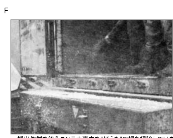
搬出作業を終えコンテナ車内を「ほうき」で掃き掃除しています。車内でこぼれた石綿を掃き掃除した際には、大量に粉じんが飛散してしまいます。
