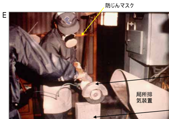
グラインダーで石綿含有物を研磨しています。写真は局所排気装置がつけられており、粉じんは効率よく排気されていますが、浮遊した繊維にはばく露するので防じんマスクも必要です。
