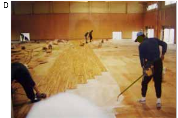
D 体育館などの木質フローリング張り。下地は鋼製二重床。石綿セメント板など2層から3層貼られています。これにフェノール樹脂配合の接着剤などで仕上げの床を貼ります。修理、解体時にばく露の可能性がります。
