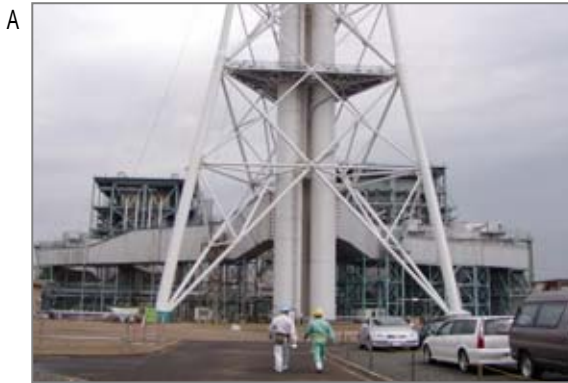
【概要】発電所には過去に多くの石綿が使用されました。現在でも耐火を目的とした建材、変電設備の防音材、発電設備の保温材・シール材、地中線用の石綿セメント管等に石綿が使用されている場合があります。解体時に石綿が飛散する可能性があります。非石綿製品への切り替えは計画的に相当以前から行われてきました。
