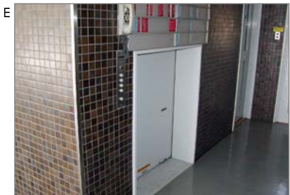
E これはダムウエイター。上下階にできたの食べ物を移動、物品倉庫では製品の上下移動に使われます。構造はエレベーターと同じです。保守・点検時に作業員がばく露する可能性があります。
